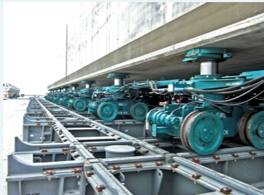
Проект Venice Mose (установка кессонов) система перемещения
